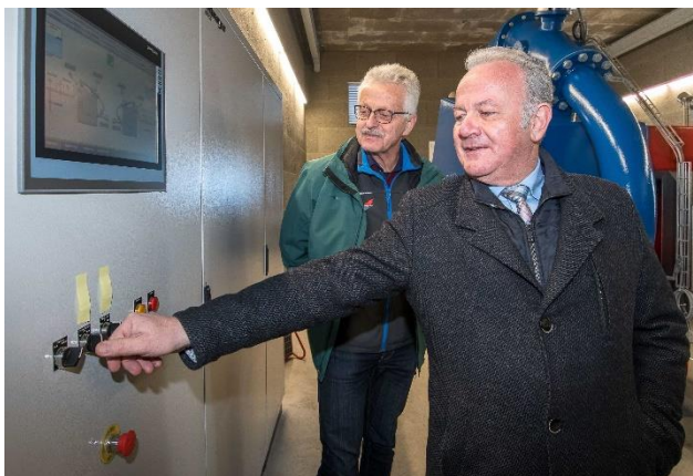
Einschalten beider Turbinen
