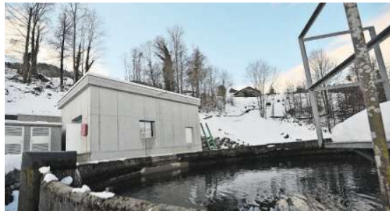
Das Kleinwasserkraftwerk Napf.
